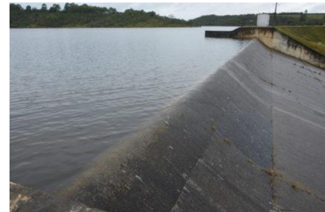
Barragens de Água Fria I e II Vitória da Conquista e Belo Campo/BA
