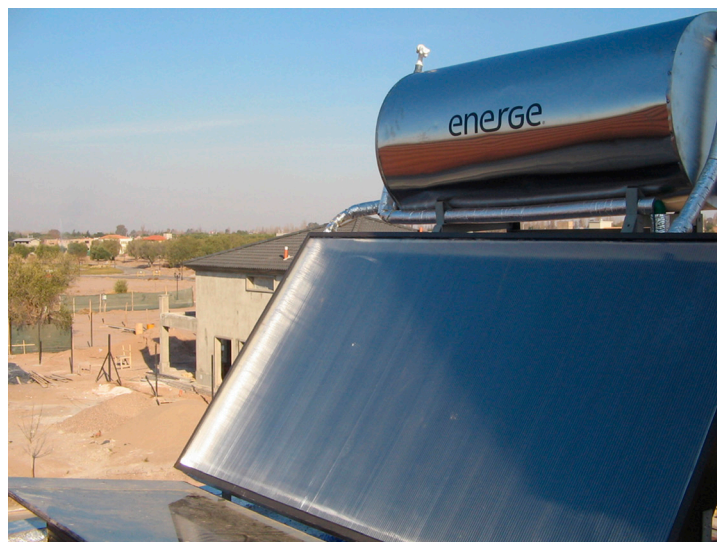
Figura 2: As placas de aquecimento solar de água se parecem muito com os módulos fotovoltaicos quando vistas de longe sobre os telhados. Fonte: Wikimedia
