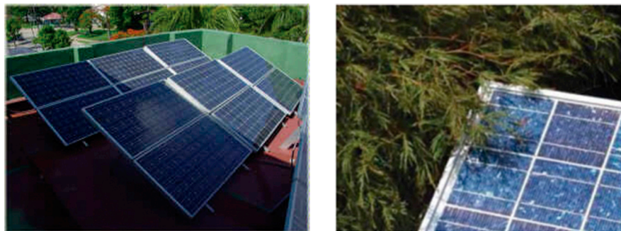
Figura 17: Instalações de módulos fotovoltaicos.
