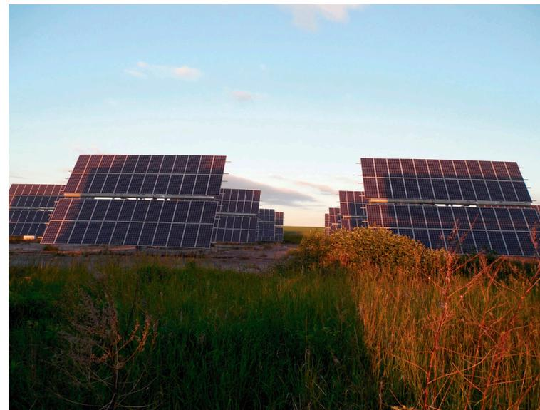
**Figura 1:** Módulos fotovoltaicos com sombreamento parcial.
