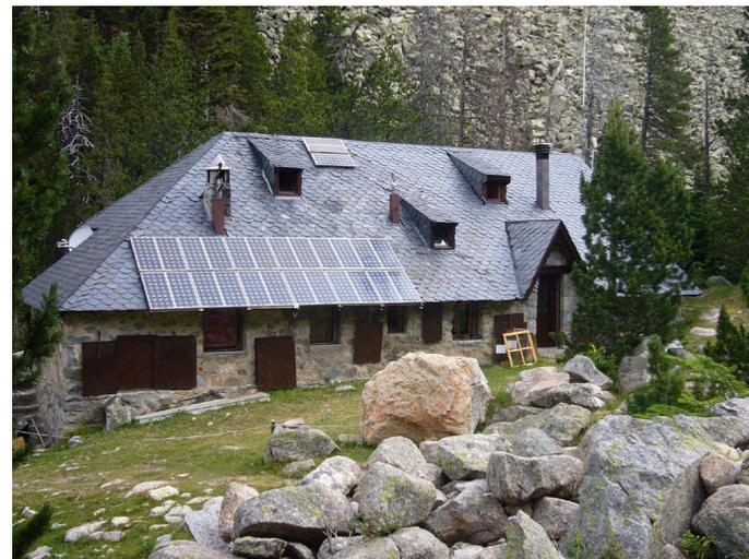
**Figura 2:** Refúgio de montanha alimentado mediante energia fotovoltaica, no Parque Nacional de Aigüestortes e Lago de San Mauricio, na Espanha.
