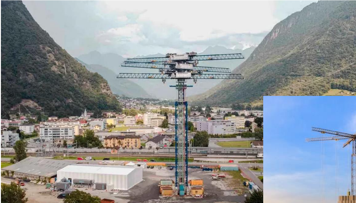
Energy Vault Ticino, Suíça
