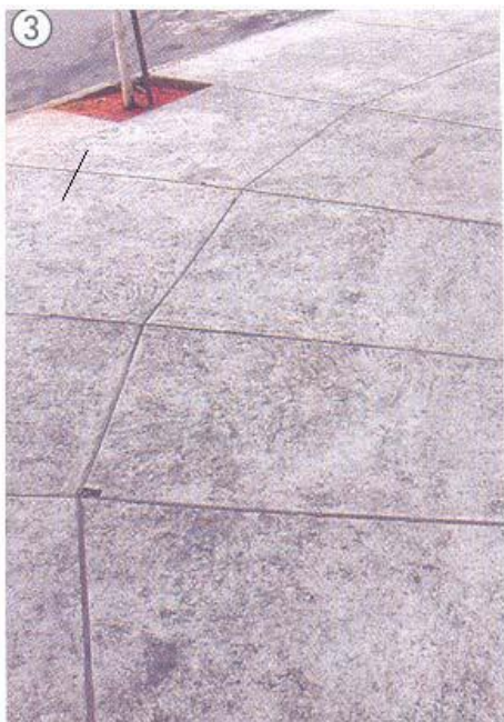
Construção de calçadas
