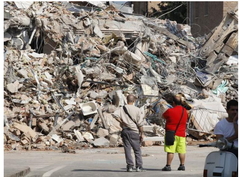
Efeitos de um terremoto Cavezzo, Itália 29/05/12
